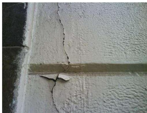
**Ilustración 10. Fisuras**
