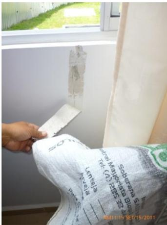
**Ilustración 6.** Fisura mal reparada
