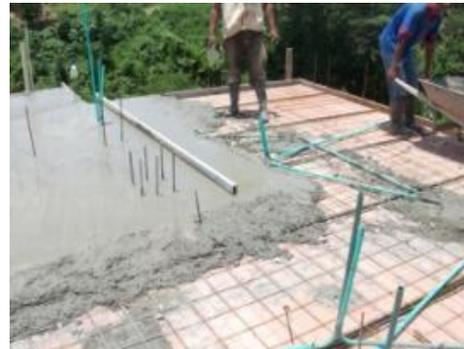
Imagen 24. Vaciado del concreto enloza
