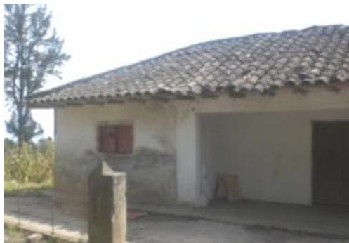
La vivienda se compone de materiales como la tapia y madera, de un piso con cubierta en teja de barro, puertas y ventanas en madera, sin ningún tipo de ornamento, 2 de sus fachadas tienen ventanas de pequeñas dimensiones, a causa del clima, ubicadas una en la cocina y en una de las habitaciones.
