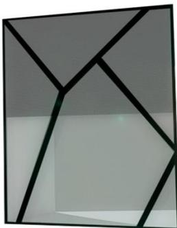
Estructura formada por polígonos irregulares, en metal que sostienen y unen el vidrio con la malla metálica
