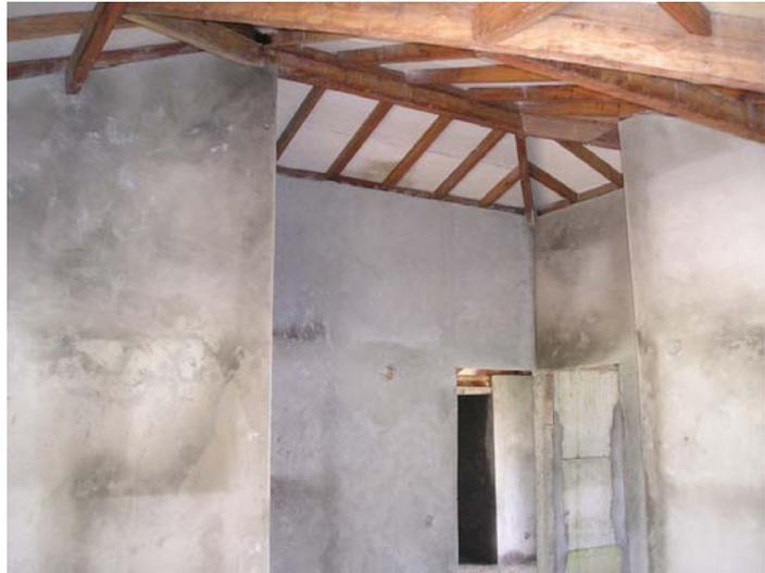
4. Cubierta con estructura de madera o metálica
