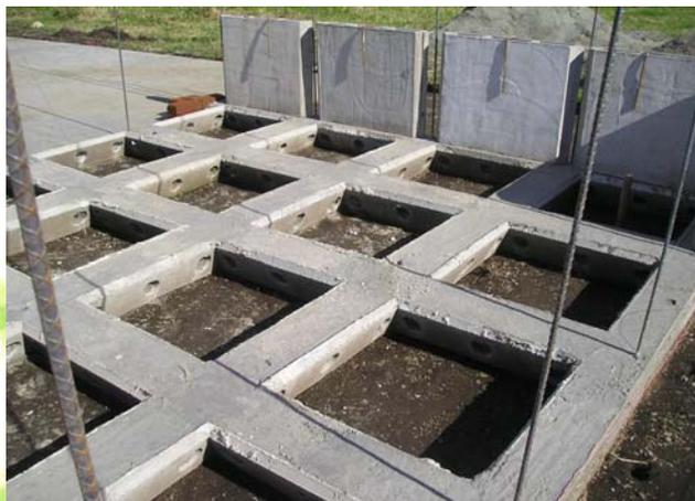
2. *Muros en elementos de concreto de medida especial de 12 cms de espesor total, con cámara interna de aire para aislamiento térmico/ acústico y modulación de 93 cms entre ejes para dovelas en concreto reforzado.*
