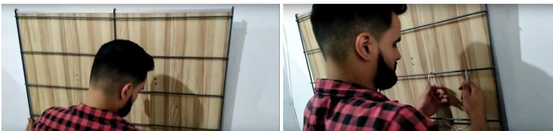
4. Fijar los modulos de tetra pak, por medio de los orificios
