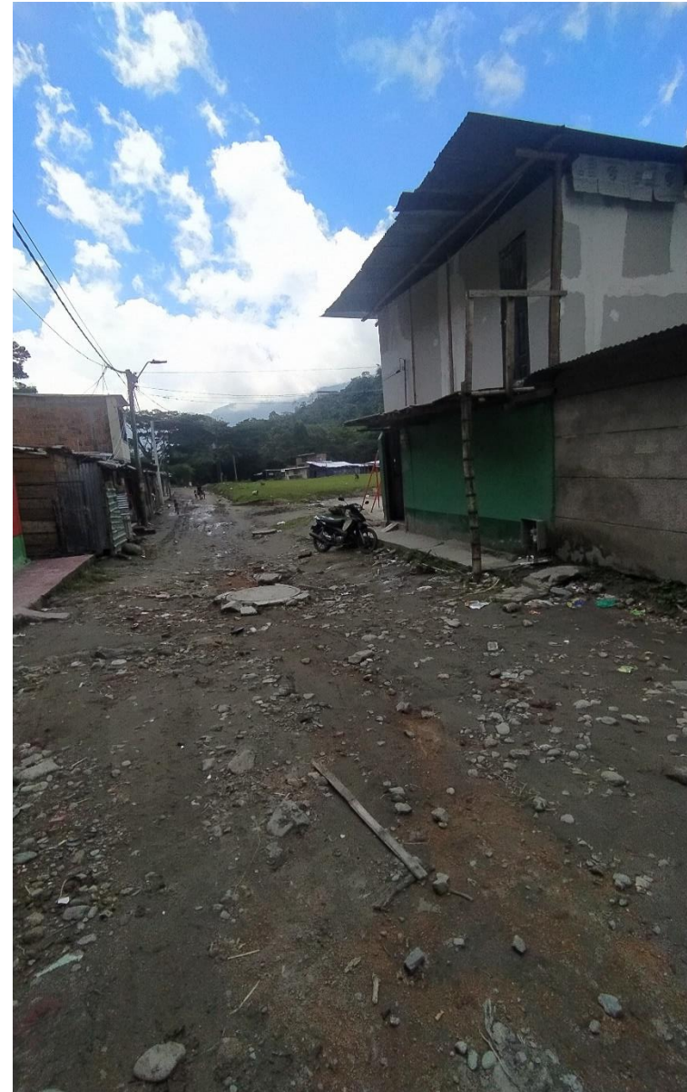
Aerofotografía panorámica: Calle Principal Barrio Baltazar (Fuente Propia)
