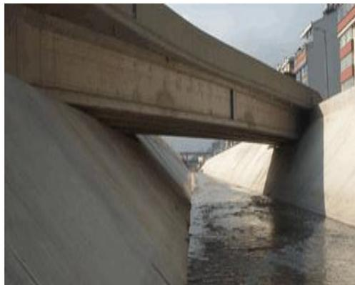
Canal de aguas lluvias con revestimiento en concreto. Obras complementarias al corredor vial de la NQS.
